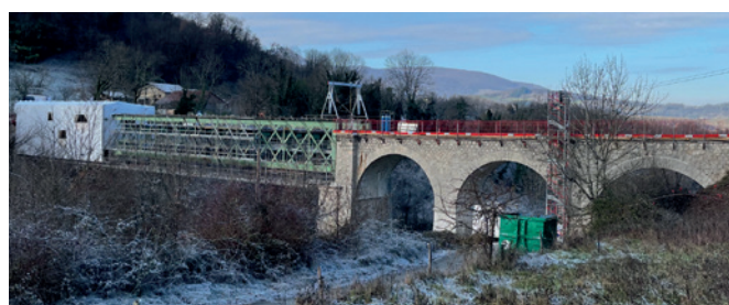
Décapage de la peinture sous la tente de confinement
