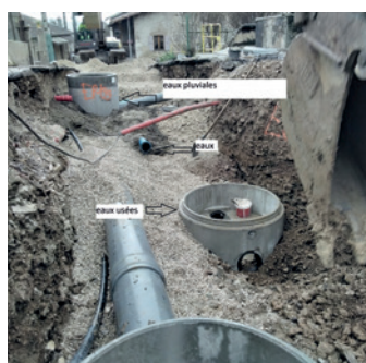
Conduite eaux pluviales
