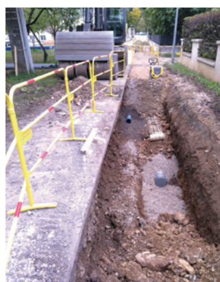
Raccord à chaque habitation des eaux pluviales
