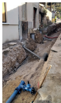
Raccord à chaque habitation des eaux pluviales
