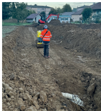
Compaction de la tranchée des eaux usées
