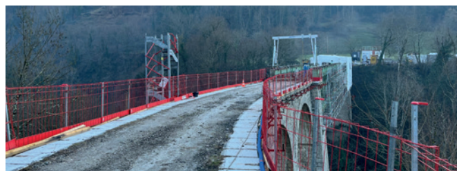
Dépose de la semelle en béton (vue côté St Laurent en Royans)
