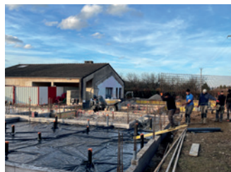
Fondations et plancher bas de la cuisine
